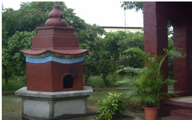
圖 2-10：金爐上方葫蘆形通風口
